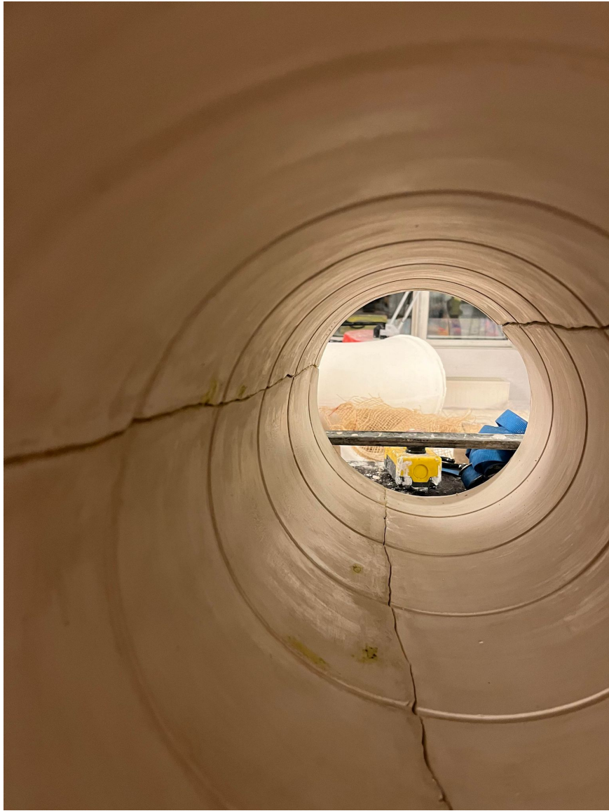
Fra innsiden av støpeform
