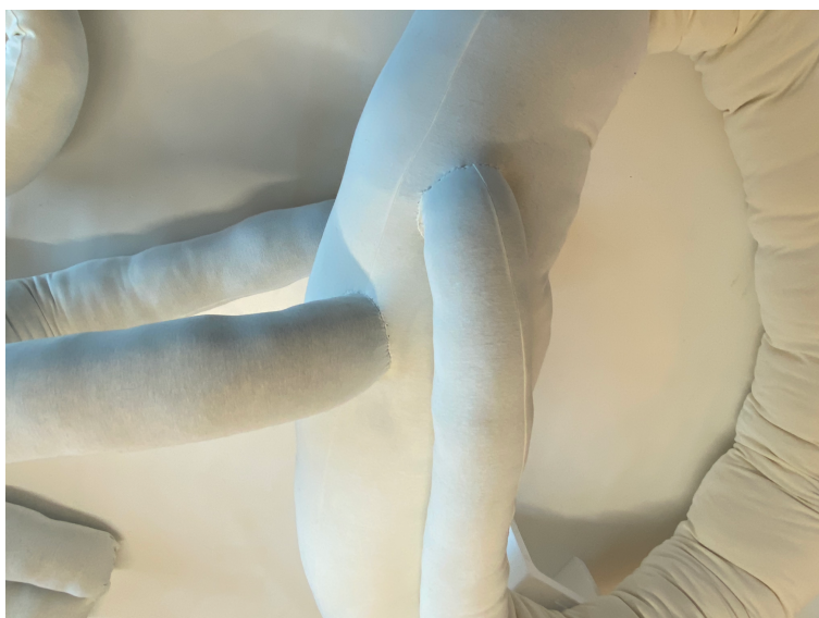
BA arbeid og ventilasjonsanlegg
