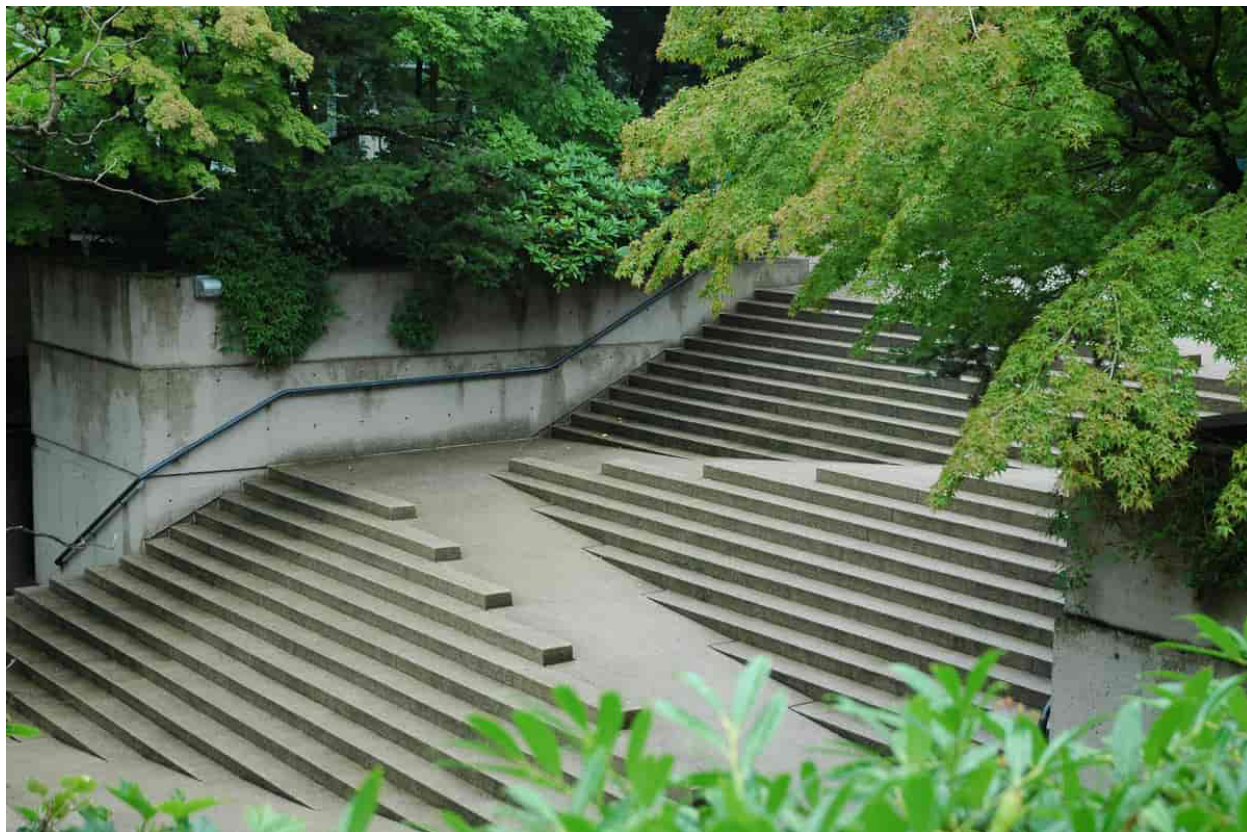
Fig 1. Stephen Beaumont (2018) [Eksempel på en rampe bygget som element i en trapp på Robson Square, Vancouver, Canada. Trappen mangler bl.a. sammenhengende rekkverk og visuell og taktil markør]
