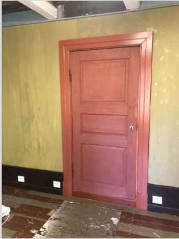
En dør «ferdig»
