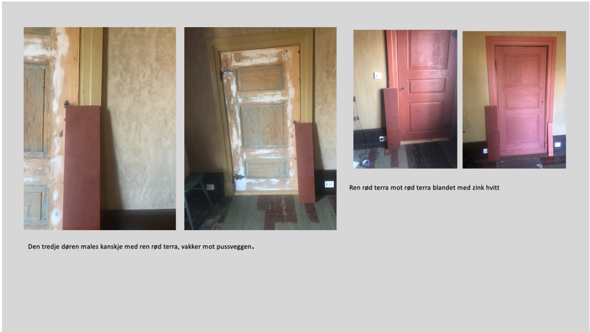
Dørene må ikke være like, de står også i to ulike veggfarger/overflater. Rødfargen frem til nå er 2/3 røde terra og 1/3 zink hvitt. (Begge fra Ottosson).
