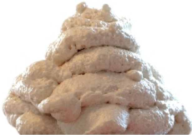
det opprinnelige byggskummet
