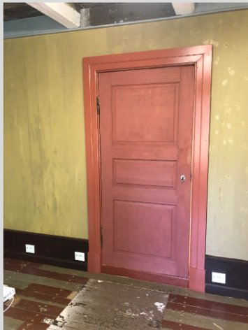
En dør «ferdig»
