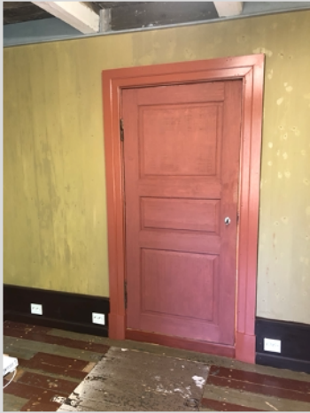
En dør «ferdig»
