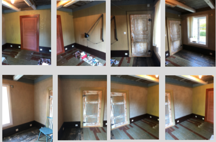
Rommet har to dører til?
