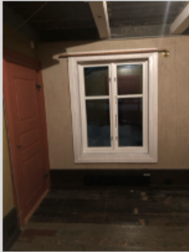
Hvit gerikt, omramming rundt vindu
