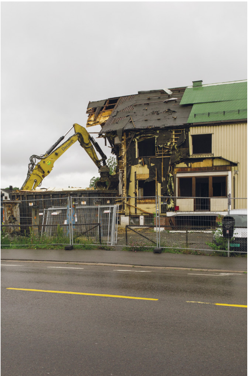
Fig. 9. Demolition of Folkets hus, Lillestrøm, 2015.
